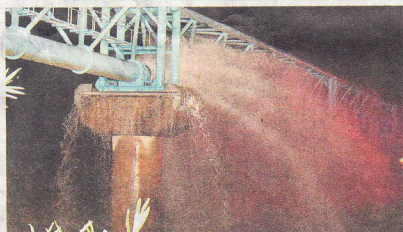
10月にあった首都圏の地震で、千葉県の水 道管から水が噴出した
